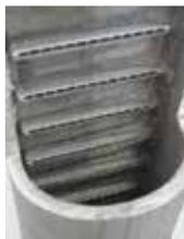
La faible résistance au passage de l'air d'une batterie à micro canaux entraîne une réduction drastique de l'énergie consommée par les moteurs électriques des ventilateurs. A capacité égale, un condenseur à micro canaux fonctionne avec une charge de fluide frigorigène inférieure jusqu'à 75% par rapport à celle d'une batterie traditionnelle.
