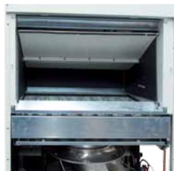
Volet mobile de free-cooling direct de climatiseur pour télécommunications
